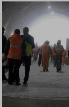
L'inaugurazione dei lavori in galleria
